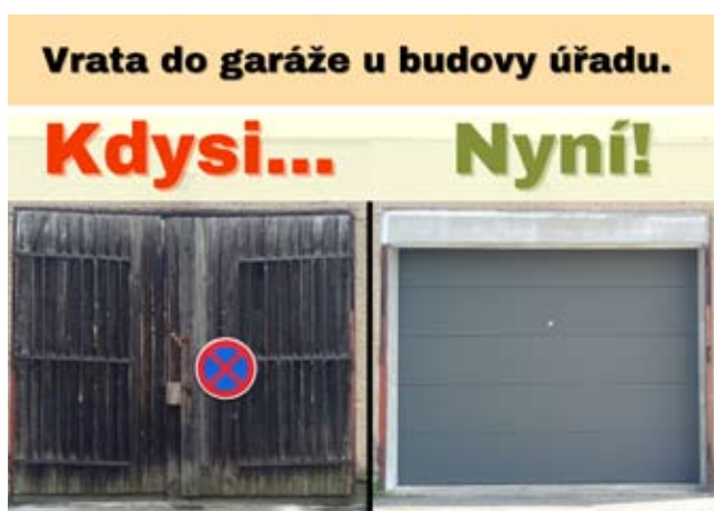
Stará vrata u garáže s technickým zázemím dosloužila a nahradila je vrata nová - moderní a elektrická. Opět skvělá práce Dana, Vojty a firmy ALUROL, spol. s.r.o.
