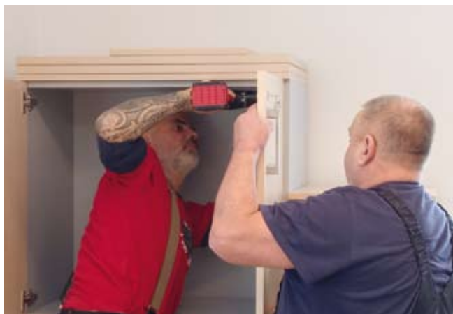
Dan a Vojta montují nový kancelářský nábytek ve zrekonstruovaných prostorech obecního úřadu.
